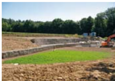
SABA im Bau Bild: Minikus Vogt & Partner AG
