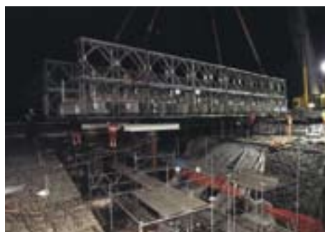
Einbau Hilfsbrücke über SBB-Glarnerlinie Bild: Fred Podolak
