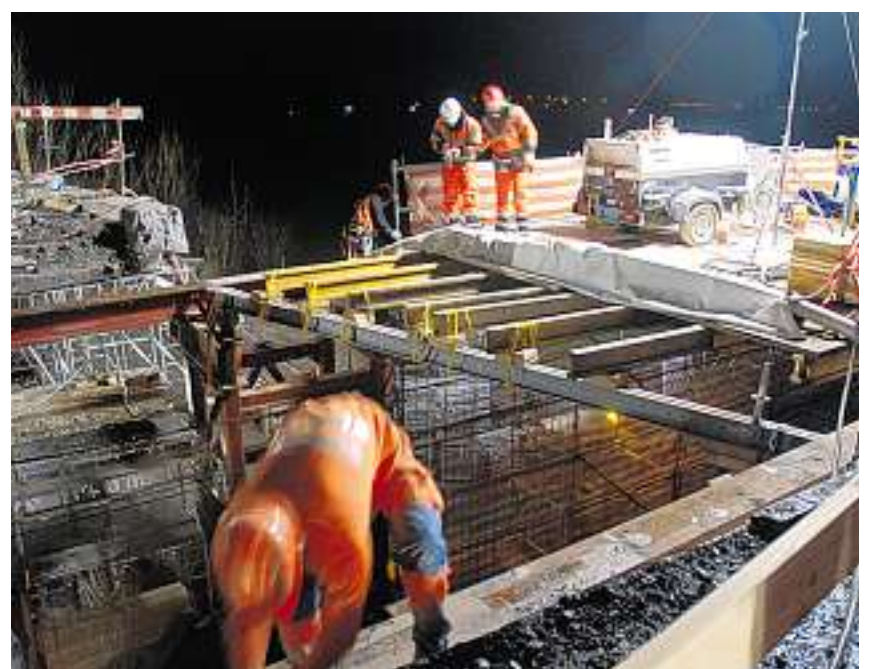
Eingerüstet: Die Bauleute arbeiten über den Geleisen.
