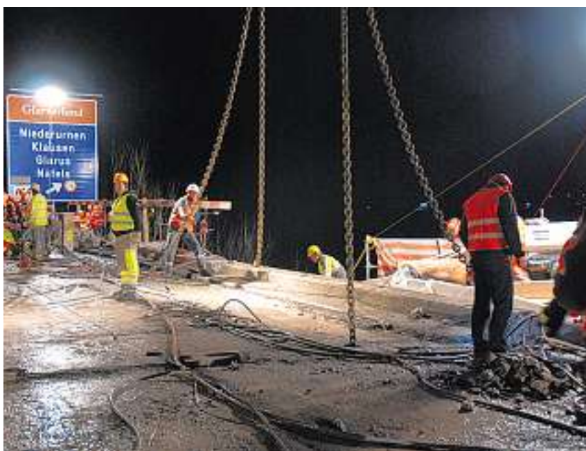
In Ketten gelegt: Die Bauarbeiter bereiten den Abtransport vor.
