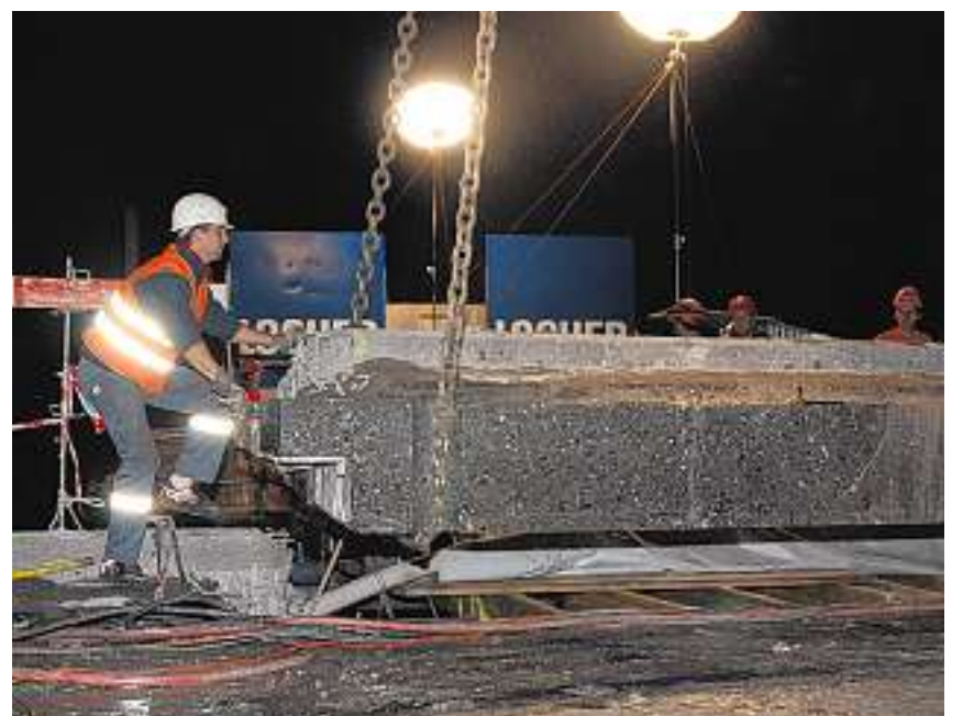
Schwerer Brocken: Das Brückenteil wird langsam angehoben.
