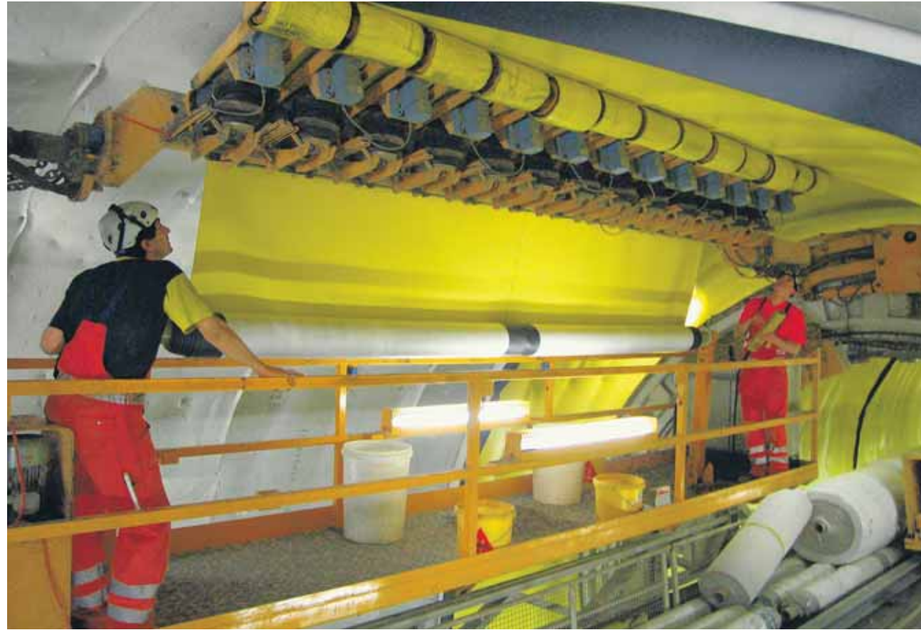
Die Rowa-Folienverlegemaschine wurde aus der Zusammenarbeit mit Abdichtungsspezialisten entwickelt.
