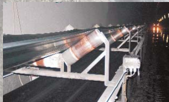
Logistik für drei Vortriebe mit 18 km Förderbandanlagen
