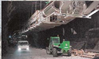
Multifunktionale Vortriebsanlagen für drei Sprengvortriebe
