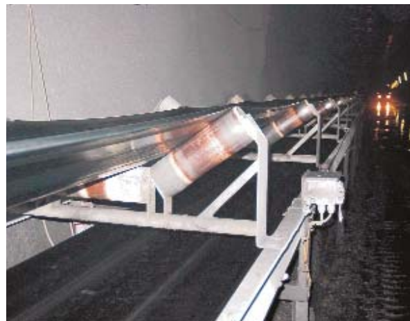
Über 18 km Förderband transportieren das Ausbruchmaterial aus drei Sprengvortrieben zur Kippstelle.
