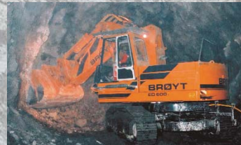
Zwei Tunnelbagger Bröyt
