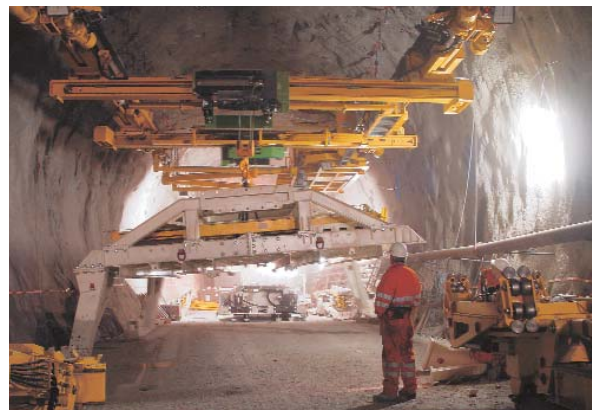
Die multifunktionale Vortriebsinstallation in der Montagephase.
