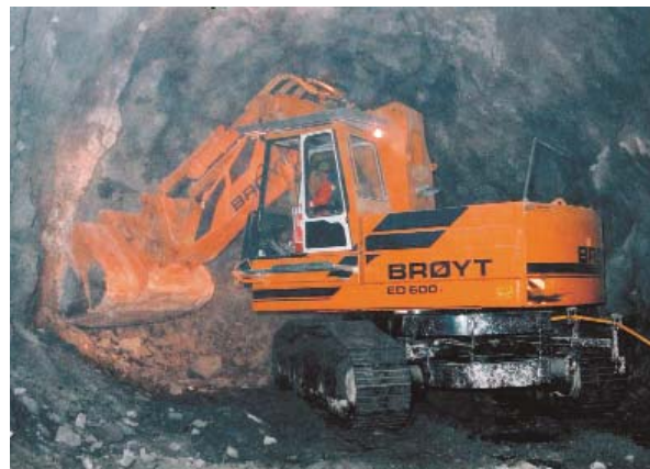
300 m 3 pro Stunde, für den Brøyt auch in engen Tunnels kein Problem.
