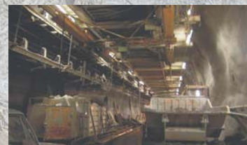
Vortriebsanlage für 5 km Sprengvortrieb
